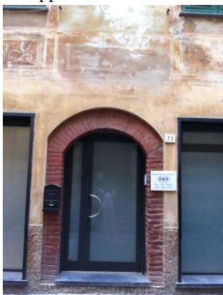
4-Rifacimento faccia vista
