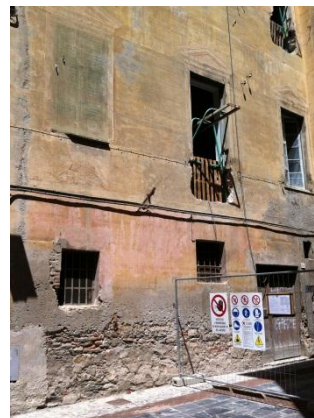
10-Demolizioni di cantiere
